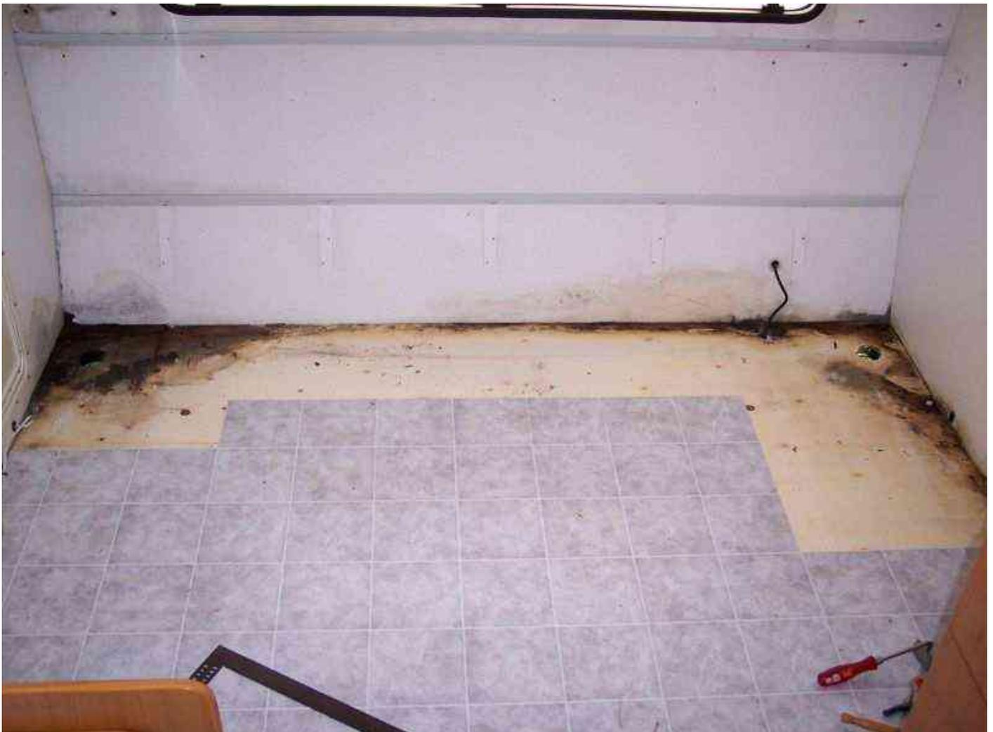
Den PVC Belag schneidet man so, dass man später möglichst keine Schnitte sieht. Hier genau am Stoß der Quadratmuster.
