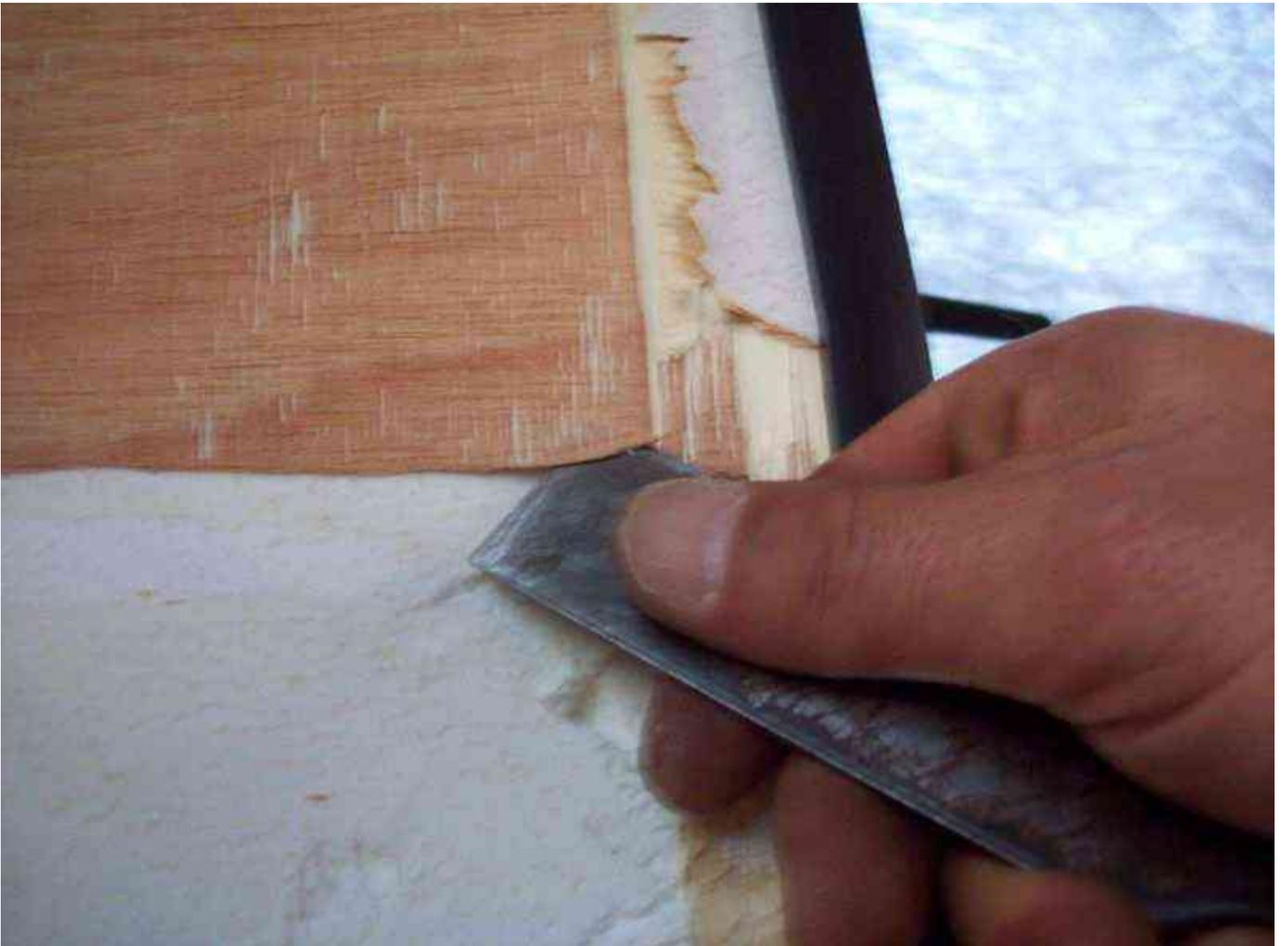
So, jetzt ist die Platte komplett ab und man sieht den Schaden am darunterliegenden Holz.
