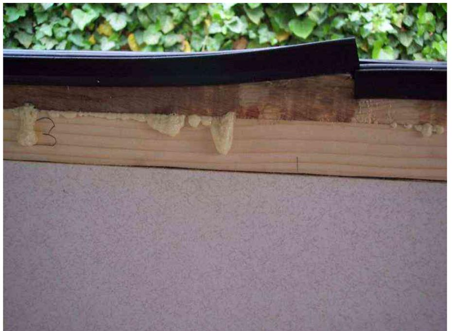
Heute hab ich dann die Platten neben und unter dem Fenster reingeklebt. Zuerst natürlich passend zuschneiden und trocken testen. Die Fläche mit den Hölzern und Styropor sollte auch schön plan sein. Ich schneide immer mit der Stichsäge zu und den Feinschliff macht dann der Handhobel und Schleifklötze. Wenn man von hinten, wie hier am Fenster rankommt, kann man die Kante anzeichnen und gleich auf Maß schneiden. Bevor geklebt wird alles herrichten was man braucht.
