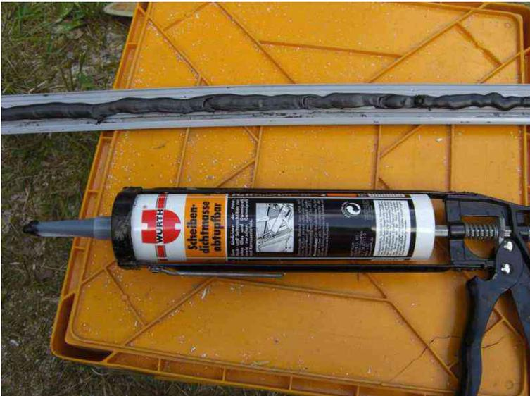
Gleiches dann mit der neuen seitlichen Schürzenleiste. Zuerst wieder alle Löcher, besonders die der offenen Schraubenköpfe mit einem Batzen Dichtmittel abgedichtet und dann die Leiste gebohrt und Dichtmittel aufgetragen. Beim Anschrauben hab ich die Leiste etwas höher gesetzt, um die vorher offenen Köpfe, zu verdecken.
